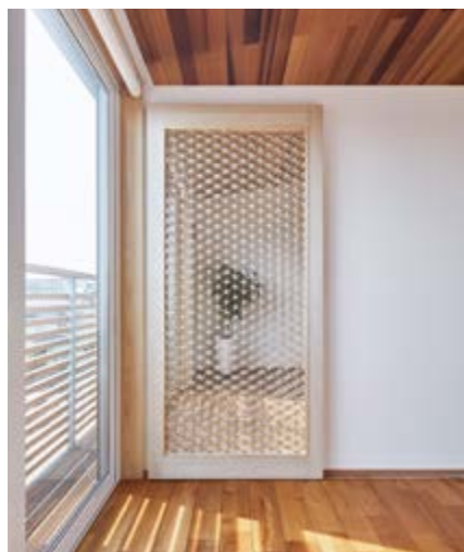
和の伝統意匠である「麻の葉格子」を使った美しい引き戸。きわめて精工で高度な技術によって製作されている
